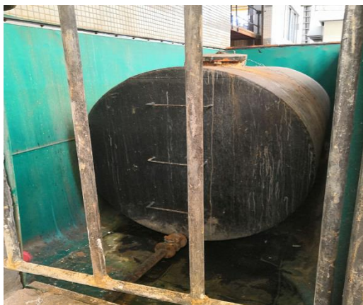
硫酸储罐已设置围堰
