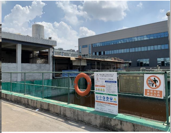
厂区事故应急池（约 900m 3 ）
